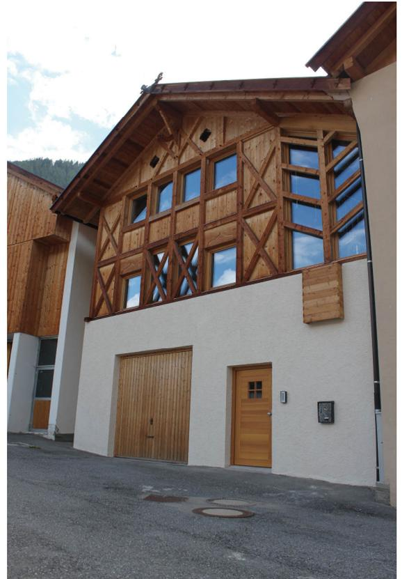
Im oberen Bereich wurden möglichst viele Felder der Außenwand geöffnet, um den Räumlichkeiten viel Tageslicht zu geben. Dabei wurde auf die feinen Details der zum Teil geschnitzten Fassade eingegangen und besonderer Wert auf eine 3-fach-Verglasung der Fenster gelegt, um so wenig Energie wie möglich zu verbrauchen. Überall trifft man auf ortstypische Materialien wie Zirbe, Lärche, Stein – in Kombination mit Metall, die zeitgemäß verarbeitet wurden.
